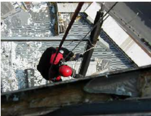
Realizzazione degli ancoraggi statici sul tetto dell'edificio
