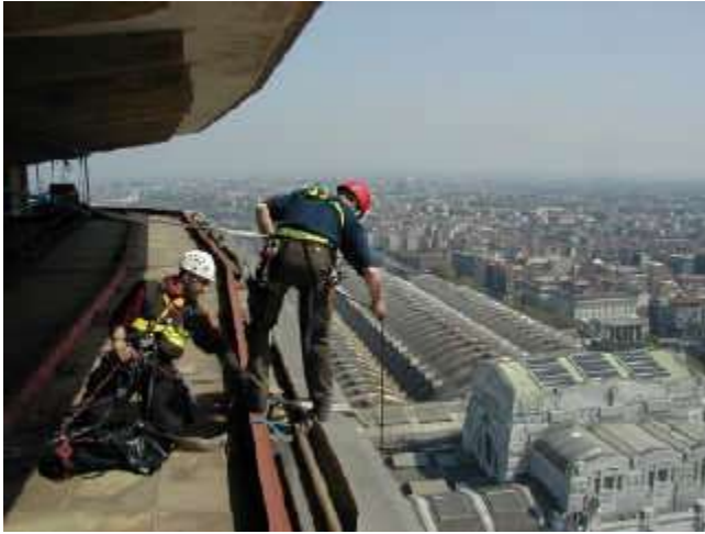
Realizzazione degli ancoraggi statici sul tetto dell'edificio
