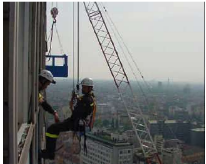
Arbeitstechnik: Aktive Abseilung im Einfachseil (halbstatisch) mit "GriGri" oder "Stop" und zusätzlich Seilklemme mit Fußpedal für Aufstieg im Arbeitsseil. Sicherungsseil (dynamisch) mit Sicherung durch "Zyper" und "Shunt".
