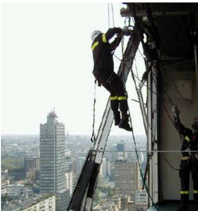
Arbeitstechnik: Aktive Abseilung im Einfachseil (halbstatisch) mit "GriGri" oder "Stop" und zusätzlich Seilklemme mit Fußpedal für Aufstieg im Arbeitsseil. Sicherungsseil (dynamisch) mit Sicherung durch "Zyper" und "Shunt".
