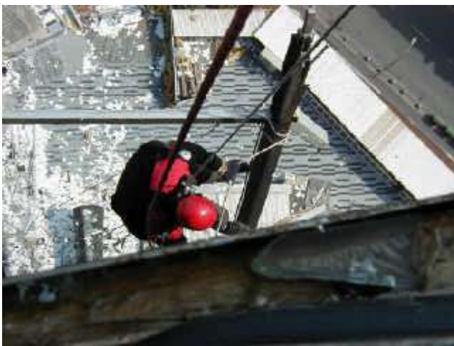
Arbeitstechnik: Aktive Abseilung im Einfachseil (halbstatisch) mit "GriGri" oder "Stop" und zusätzlich Seilklemme mit Fußpedal für Aufstieg im Arbeitsseil. Sicherungsseil (dynamisch) mit Sicherung durch "Zyper" und "Shunt".
